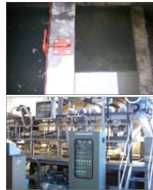
유수분리기 설치 대전공장 폐수처리장 노후 탈수기 교체
