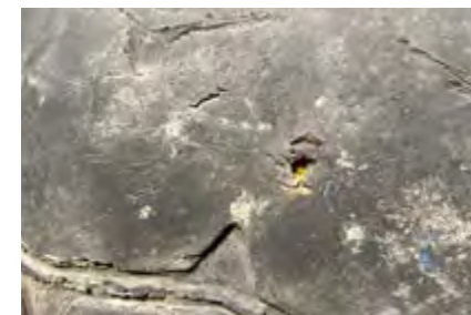
<Nappes métalliques du pneu rouillées>
