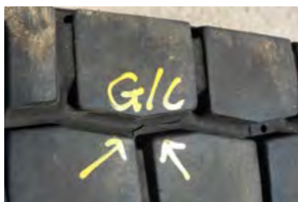
<Fissure des rainures de type 2>
